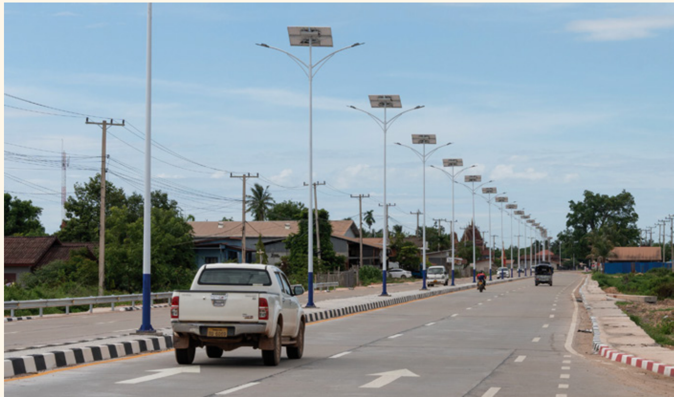
ມີການຕິດຕັ້ງດອກໄຟແສງຕາເວັນຕາມຖະໜົນທີ່ມີການປັບປຸງໃຫມ່ ຕາມການຂະຫຍາຍຕົວຂອງນະຄອນຫຼວງວຽງຈັນ.
